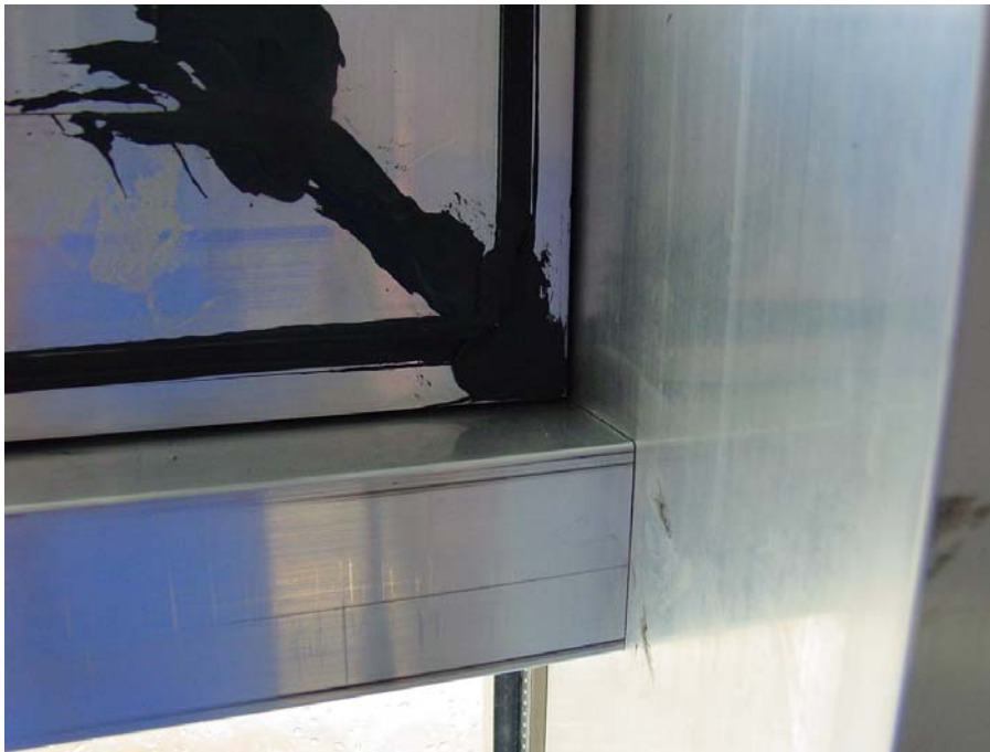
Bild 4 Vollständige Abdichtung des Einsatzfensters (ohne Bewertung)
