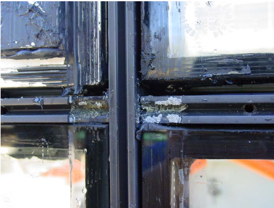
Bild 14 Isolatoren am Kreuzungspunkt
