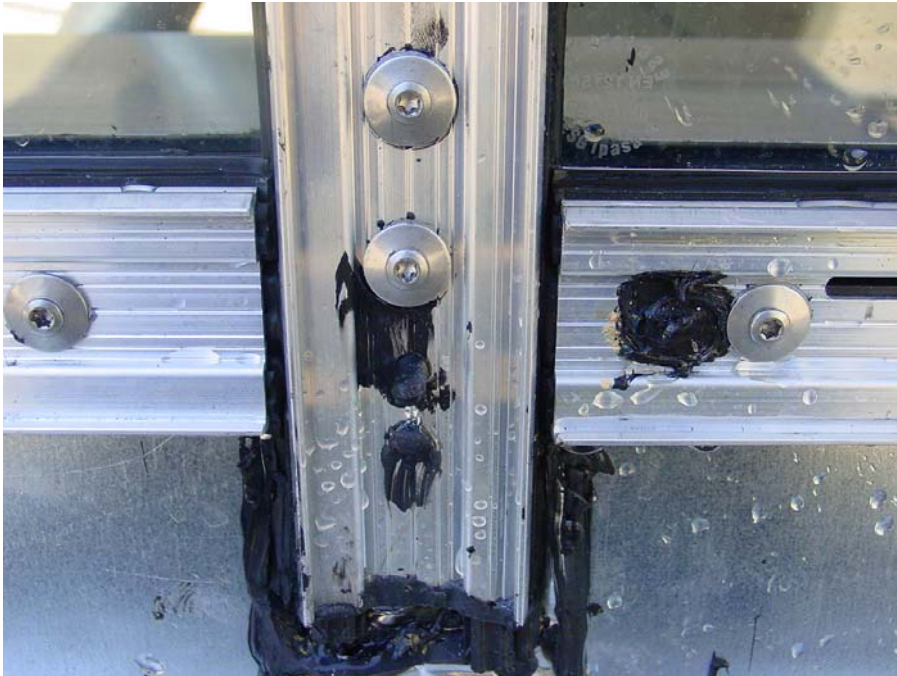
Bild 17 Andruckleisten am Sockelpunkt
