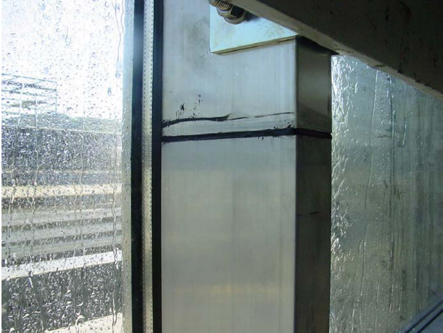
Bild 19 Pfostenstoß
