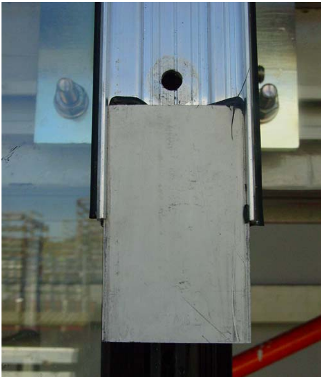
Bild 20 Klemmleistenstoß
