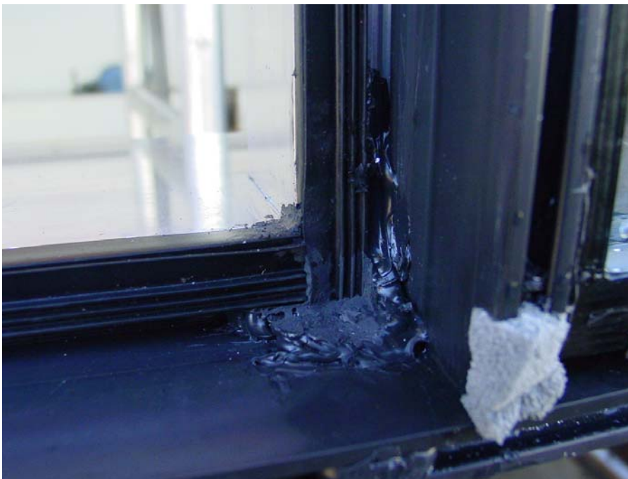
Bild 10 Eckausbildung innere Verglasungsdichtung am Riegel / Riegel Stoß
