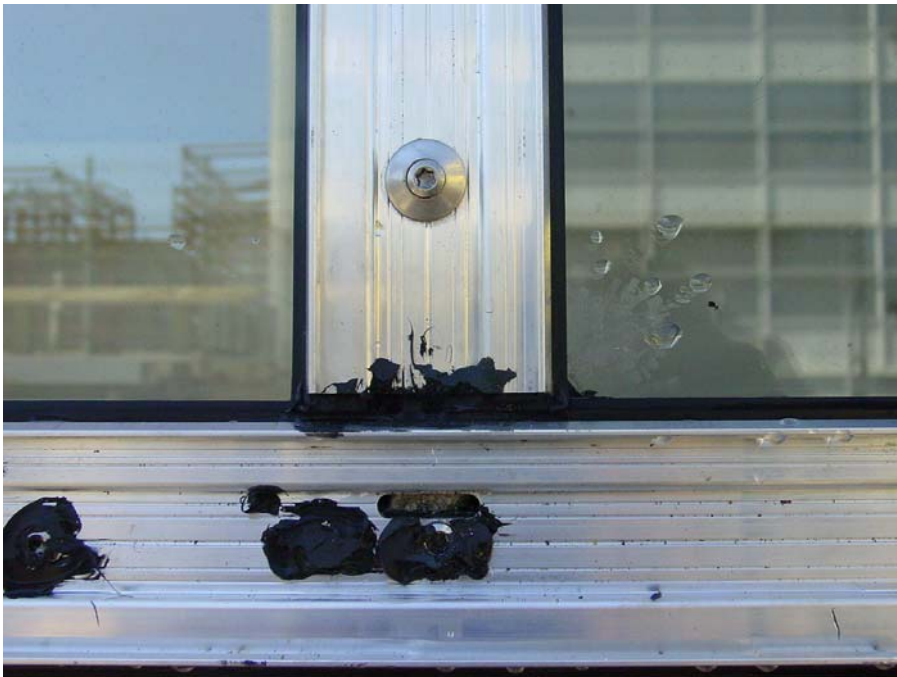
Bild 8 Andruckleisten am Riegel / Riegel Stoß
