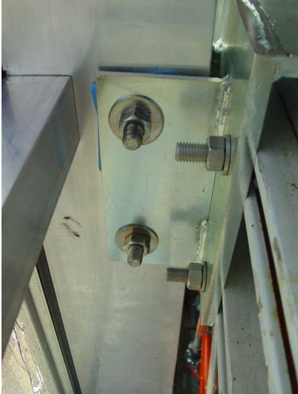
Bild 23 Fassadenbefestigung
