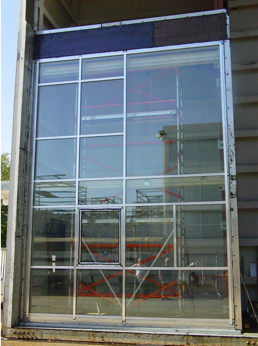
Bild 1 Fassade in Prüfstand eingebaut
