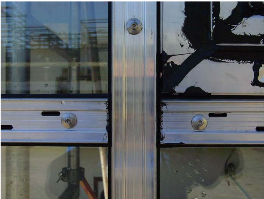
Bild 12 Andruckleisten mit Entwässerung / Belüftung am Kreuzungspunkt
