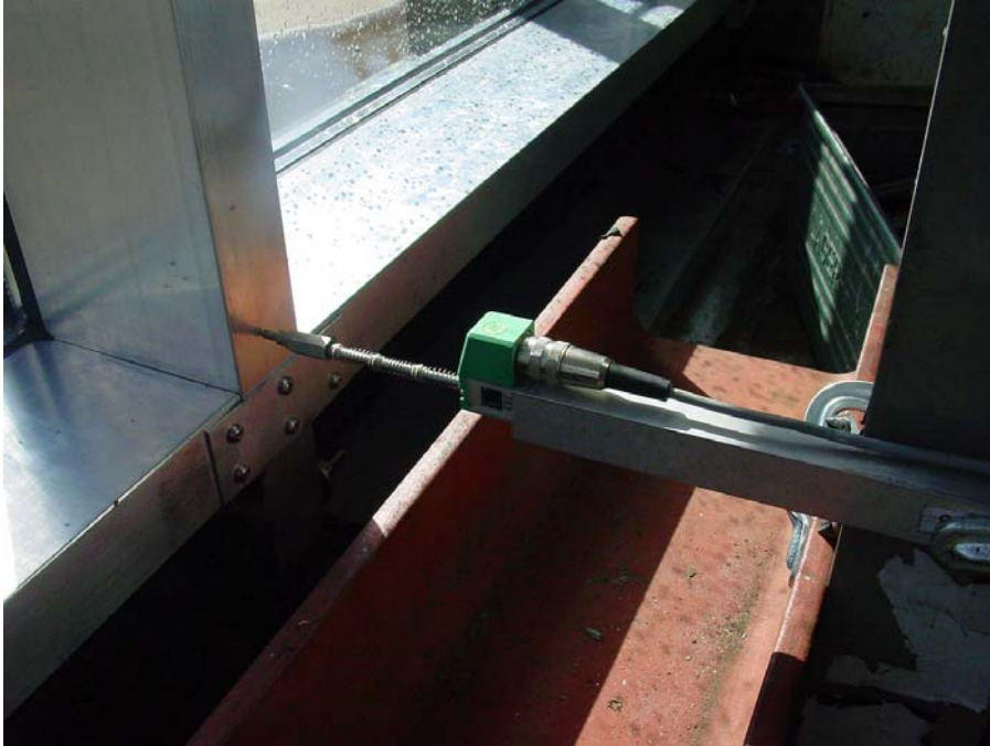
Bild 3 Messung der Lageveränderung durch angebrachte Wegaufnehmer
