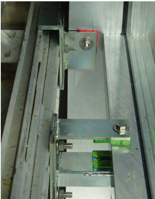
Bild 24 Fassadenbefestigung seitlich und Riegelbefestigung (oberer Riegel)
